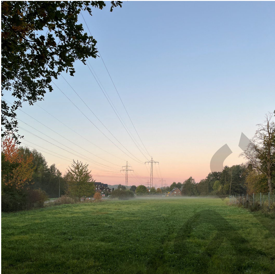
Bild 2-2: 110 kV Freileitungstrassen am betreffenden Bebauungsgebiet
