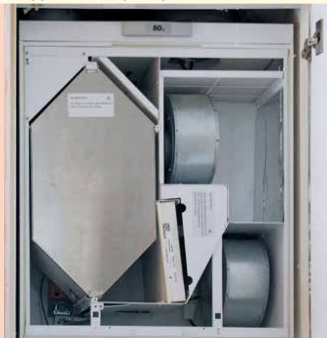
Lüftungsgerät mit Wärmerückgewinnung
