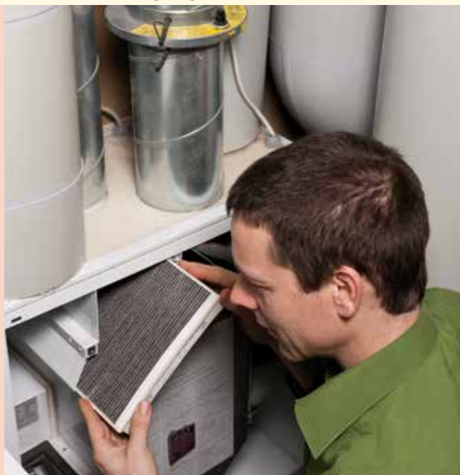
Filterwechsel an der Lüftungsanlage
