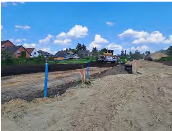
Abb. 15: Einbau des HW 9 innerhalb der Baufelder/Baugrenze
