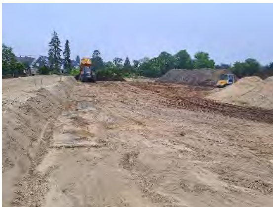
Abb. 33: Umlagerung des ungesiebten Materials von Los 1 auf Los 3a
