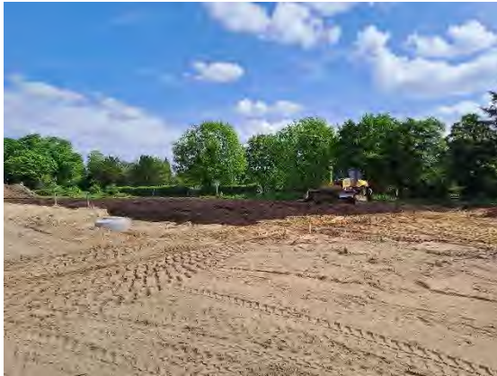
Abb. 52: Einbau HW 3/HW 5 auf Los 4c innerhalb der Baufelder/Baugrenze
