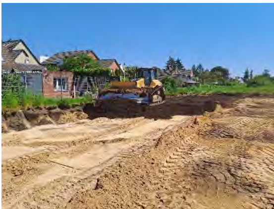
Abb. 11: Einbau des HW 4 außerhalb der Baufelder/Baugrenze und außerhalb der durchwurzelbaren Schicht
