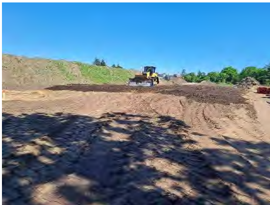
Abb. 60: Einbau von ungesiebt Material innerhalb und außerhalb der Baufelder/Baugrenze in Los 4a
