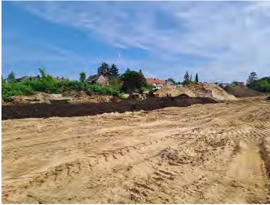
Abb. 21: Einbau des HW 6 außerhalb der Baufelder/Baugrenze und außerhalb der durchwurzelbaren Schicht
