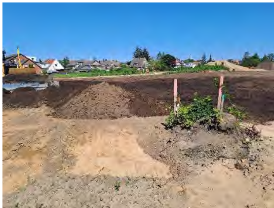
Abb. 29: Einbau von ungesiebt Material innerhalb und außerhalb der Baufelder/Baugrenze
