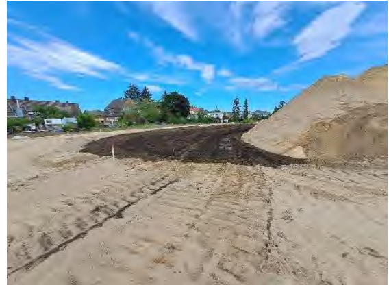
Abb. 44: Einbau von ungesiebt Material innerhalb und außerhalb der Baufelder/Baugrenze; Zwischenlagerung des Unterbodens (Sand)
