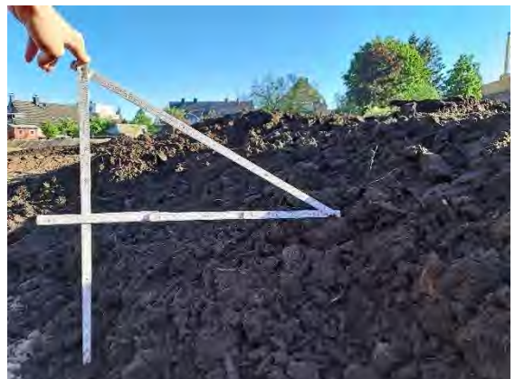
Abb. 40: Einbaumächtigkeit des ungesiebt Materials von > 30 cm als durchwurzelbare Schicht
