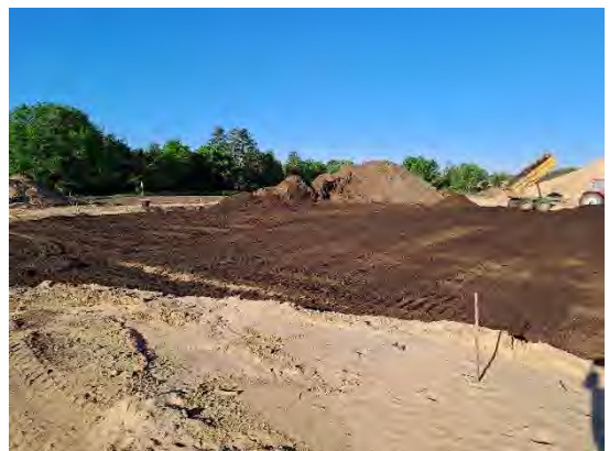
Abb. 42: Einbau von ungesiebt Material innerhalb und außerhalb der Baufelder/Baugrenze
