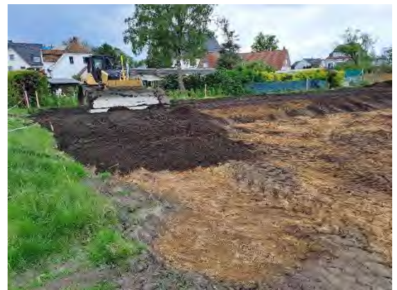
Abb. 6: Einbau des HW 10 innerhalb der Baufelder/Baugrenze
