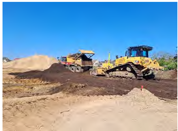
Abb. 34: Einbau des HW 11 außerhalb der Baufelder/Baugrenze und außerhalb der durchwurzelbaren Schicht
