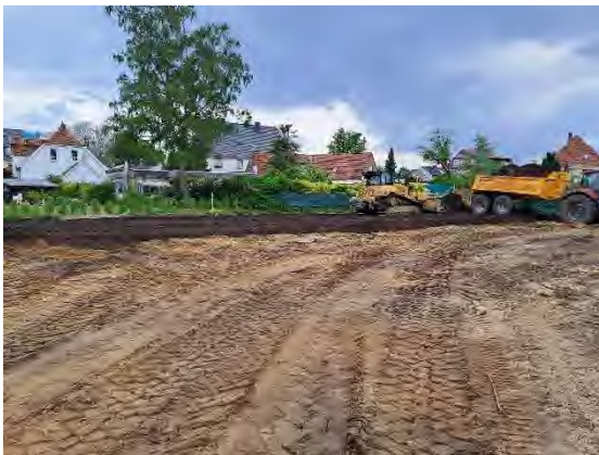
Abb. 3: Einbau des HW 2 außerhalb der Baufelder/Baugrenze und außerhalb der durchwurzelbaren Schicht
