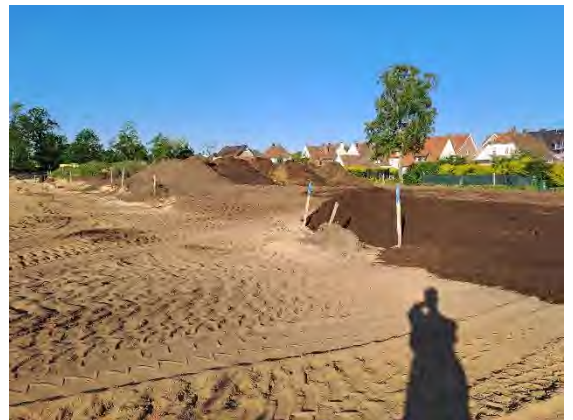
Abb. 16: Um- und Zwischenlagerung des restlichen HW 10 und HW 9 auf Los 1 zum Zeitpunkt der Fertigstellung
