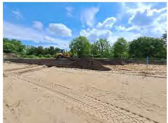
Abb. 51: Einbau HW 3/ HW 5 auf Los 4c innerhalb der Baufelder/Baugrenze
