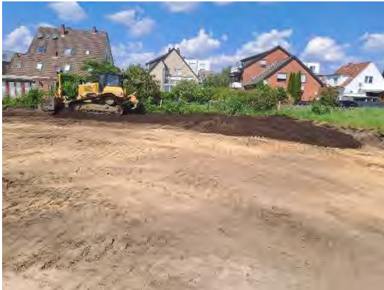
Abb. 13: Einbau des HW 9 außerhalb der Baufelder/Baugrenze als durchwurzelbare Schicht
