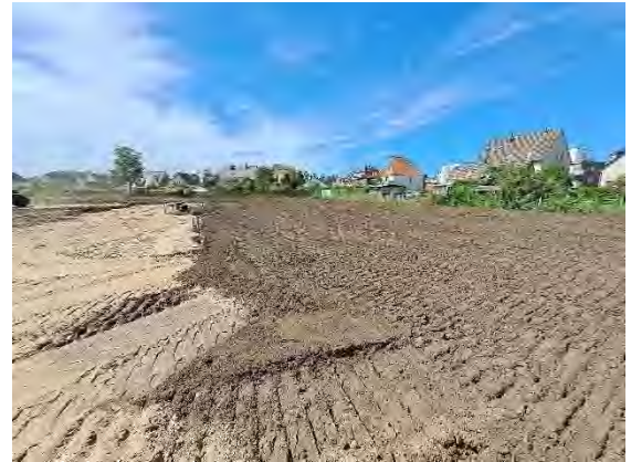
Abb. 20: Fertigstellung Bodeneinbau Los 1, westliche Blickrichtung
