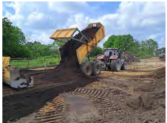
Abb. 55: Einbau des Materials (HW 2) außerhalb der geplanten Baufelder/Baugrenze und außerhalb der durchwurzelbaren Schicht in Los 4b
