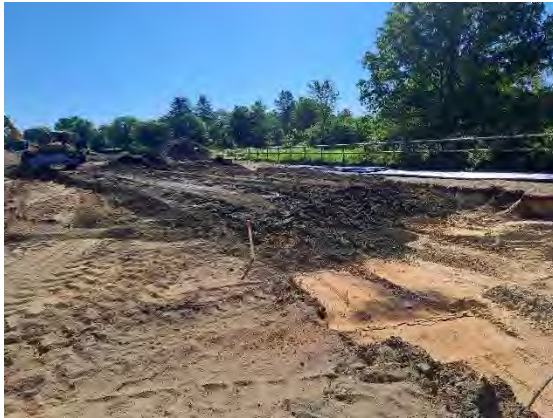
Abb. 58: Einbau des HW 2 außerhalb der Baufelder/Baugrenze und außerhalb der durchwurzelbaren Schicht auf Los 4a
