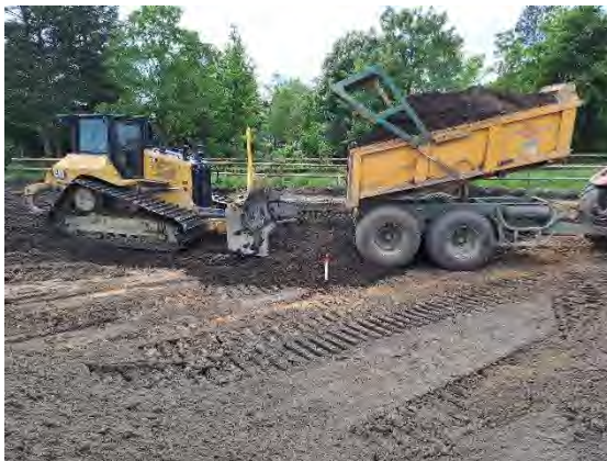
Abb. 54: Einbau des Materials (HW 2) außerhalb der geplanten Baufelder/Baugrenze und außerhalb der durchwurzelbaren Schicht in Los 4b
