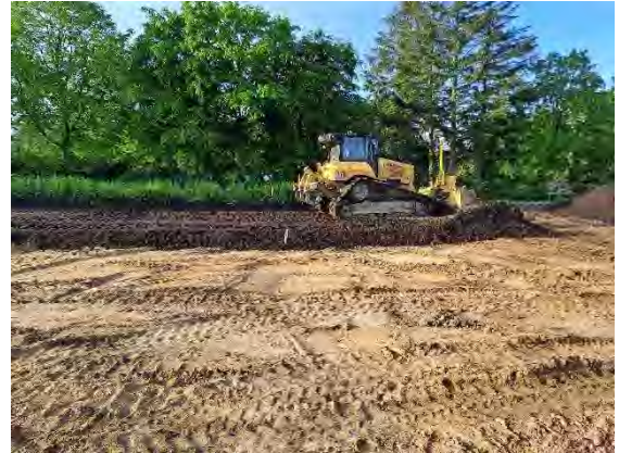
Abb. 47: Einbau des Materials (HW 7) außerhalb der geplanten Baufelder/Baugrenze und außerhalb der durchwurzelbaren Schicht in Los 4c
