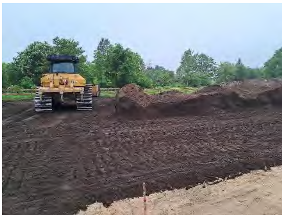
Abb. 56: Einbau HW 8 auf Los 4b innerhalb der Baufelder und außerhalb der Baufelder/Baugrenze als durchwurzelbare Schicht
