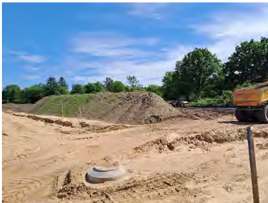
Abb. 62: Rückhalt/Zwischenlagerung des HW 1 (auf Los 4a) bis zum Einbau der Böschung am Wendehammer/Andeckungsarbeiten
