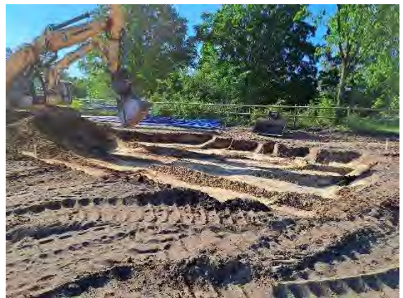
Abb. 57: Ausbau des Unterbodens außerhalb des Baufeldes/Baugrenze auf Los-Fläche 4a
