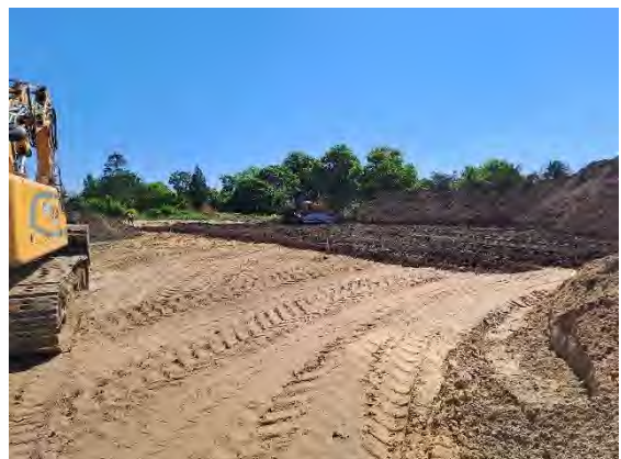
Abb. 36: Einbau des HW 11 außerhalb der Baufelder/Baugrenze und außerhalb der durchwurzelbaren Schicht
