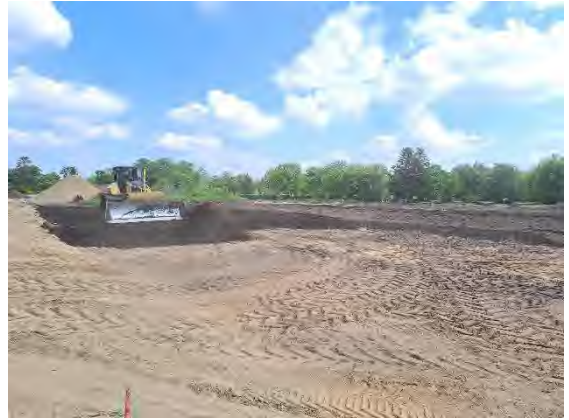
Abb. 22: Einbau von ungesiebt Material innerhalb der Baufelder/Baugrenze
