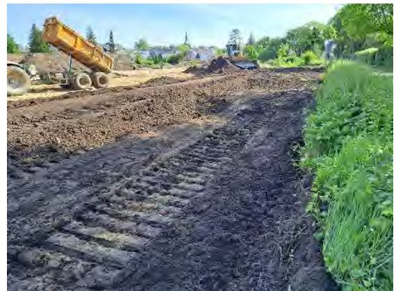
Abb. 49: Einbau HW 3 auf Los 4c innerhalb der Baufelder/Baugrenze und außerhalb der Baufelder als durchwurzelbare Schicht
