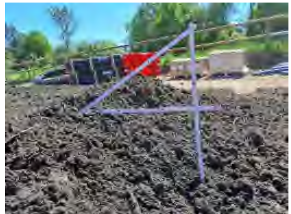
Abb. 61: Einbaumächtigkeit (ungesiebt Material) von > 30 cm als durchwurzelbare Schicht
