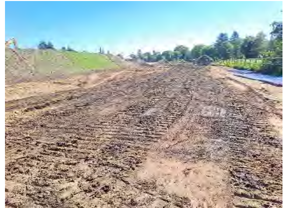
Abb. 59: abgeschlossener Einbau des HW 2 außerhalb der Baufelder/Baugrenze und außerhalb der durchwurzelbaren Schicht auf Los 4a
