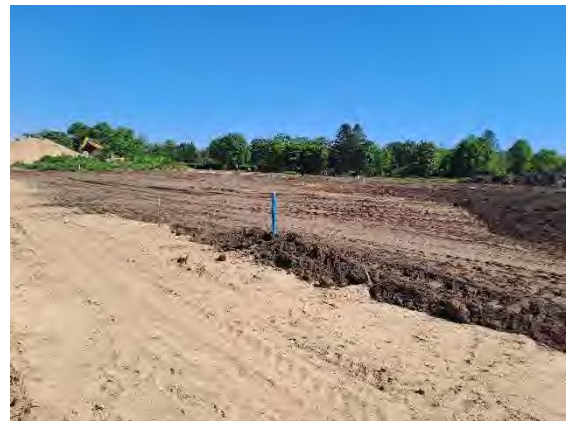
Abb. 30: Fertigstellung Bodeneinbau Los 2, südöstliche Blickrichtung
