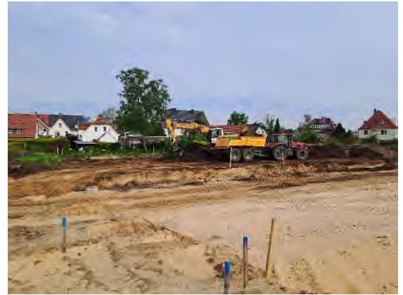
Abb. 2: Verladung zur Umlagerung des ungesiebten Materials von Los 1 in Los 3b
