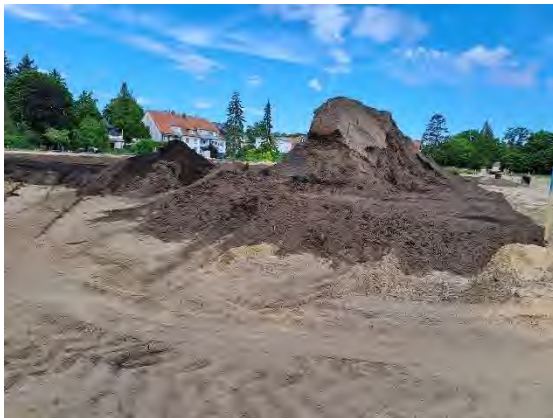
Abb. 45: Rückhalt/Zwischenlagerung des restlichen ungesiebt Materials für den Bereich, der zum Zeitpunkt des Einbaus zur Zwischenlagerung des ausgebauten Unterbodens dient
