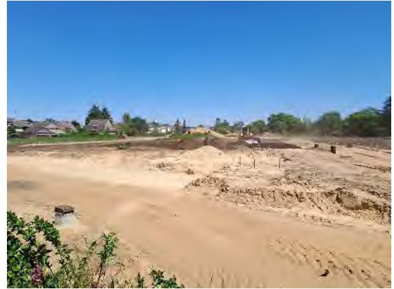
Abb. 28: Einbau von ungesiebt Material innerhalb und außerhalb der Baufelder/Baugrenze
