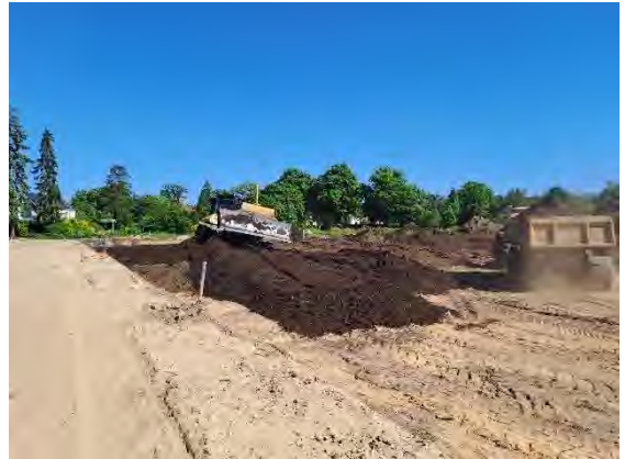
Abb. 38: Verteilung/Einbau von ungesiebt Material innerhalb und außerhalb der Baufelder/Baugrenze
