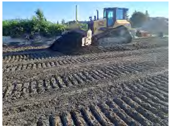
Abb. 24: Einbau von ungesiebt Material außerhalb der Baufelder/Baugrenze als durchwurzelbare Schicht
