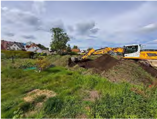
Abb. 1: Verladung zur Umlagerung des ungesiebten Materials von Los 1 in Los 3b
