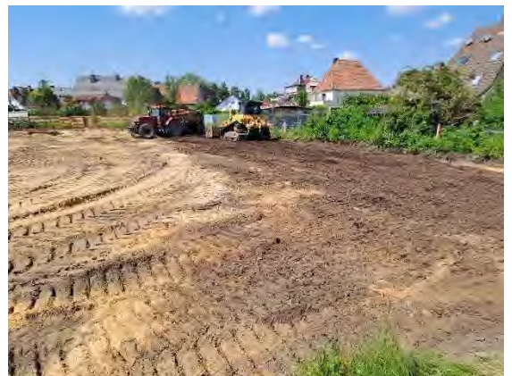
Abb. 12: Einbau des HW 4 außerhalb der Baufelder/Baugrenze und außerhalb der durchwurzelbaren Schicht
