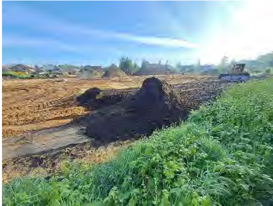
Abb. 46: Einbau des Materials (HW 7) außerhalb der geplanten Baufelder/Baugrenze und außerhalb der durchwurzelbaren Schicht in Los 4c
