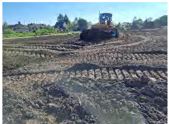
Abb. 26: Einbau von ungesiebt Material außerhalb der Baufelder/Baugrenze als durchwurzelbare Schicht
