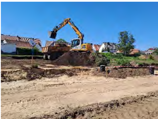
Abb. 17: Verladung zur Umlagerung des ungesiebten Materials von Los 1 in Los 3b
