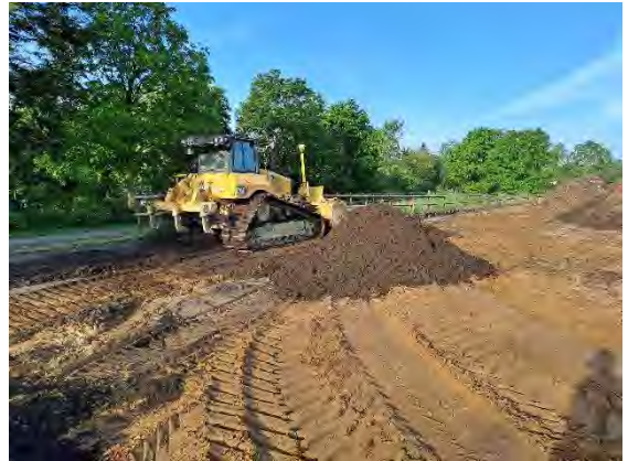
Abb. 53: Einbau des Materials (HW 7) außerhalb der geplanten Baufelder/Baugrenze und außerhalb der durchwurzelbaren Schicht in Los 4b
