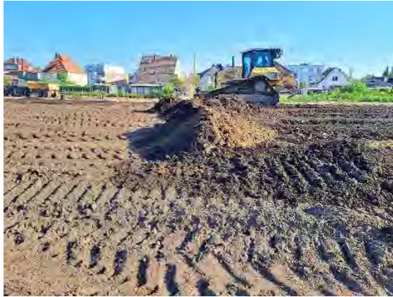
Abb. 27: Einbau von ungesiebt Material außerhalb der Baufelder/Baugrenze als durchwurzelbare Schicht
