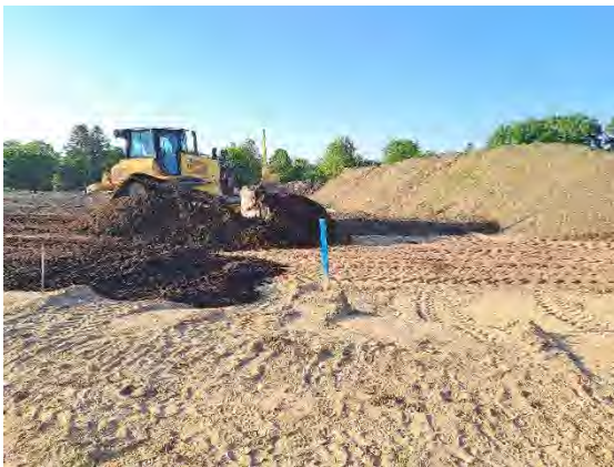
Abb. 23: Einbau von ungesiebt Material innerhalb der Baufelder/Baugrenze
