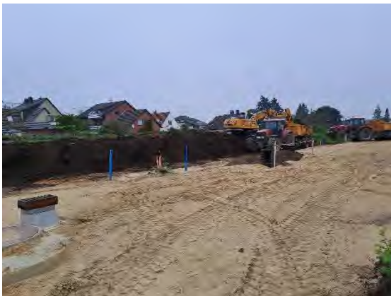
Abb. 9: Verladung zur Umlagerung des ungesiebten Materials von Los 1 in Los 3a
