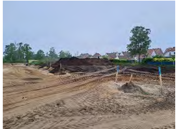
Abb. 8: Um- und Zwischenlagerung des restlichen HW 10 auf Los 1 zum Zeitpunkt der Fertigstellung eines Teilbereichs
