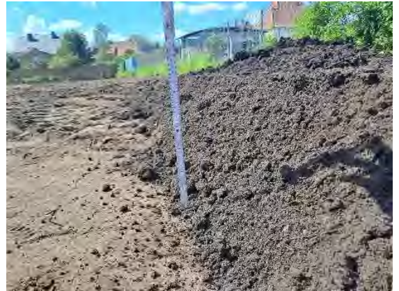
Abb. 14: Einbaumächtigkeit (HW 9) von > 30 cm als durchwurzelbare Schicht
