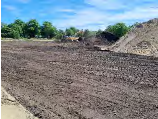
Abb. 43: Einbau von ungesiebt Material innerhalb und außerhalb der Baufelder/Baugrenze
