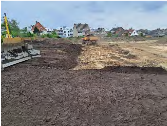
Abb. 7: Einbau des HW 10 innerhalb der Baufelder/Baugrenze
