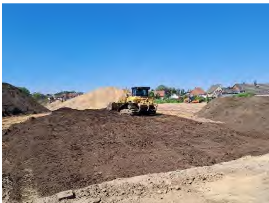
Abb. 35: Einbau des HW 11 außerhalb der Baufelder/Baugrenze und außerhalb der durchwurzelbaren Schicht
