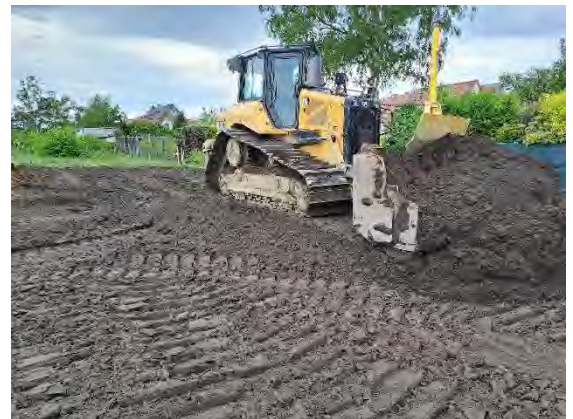
Abb. 4: Einbau des HW 10 außerhalb der Baufelder/Baugrenze als durchwurzelbare Schicht
