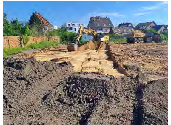
Abb. 10: Ausbau des Unterbodens außerhalb der Baufelder/Baugrenze
