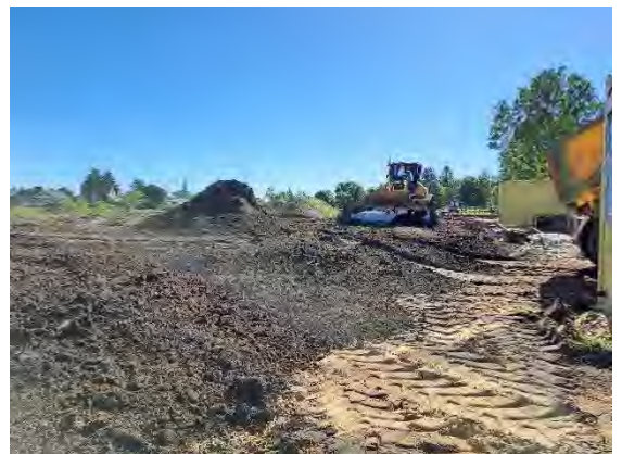
Abb. 18: Einbau des HW 9 und HW 10 innerhalb und außerhalb der Baufelder/Baugrenze; Teilfläche neben den Baucontainern
