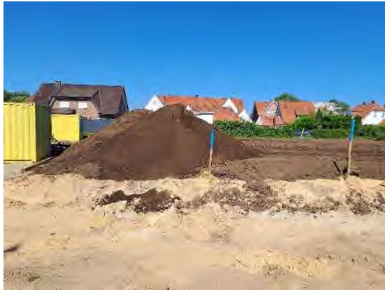
Abb. 19: Rückhalt/Zwischenlagerung des restlichen HW 9 und HW 10 für die zum Zeitpunkt des Bodeneinbaus mit Baucontainern blockierten Fläche
