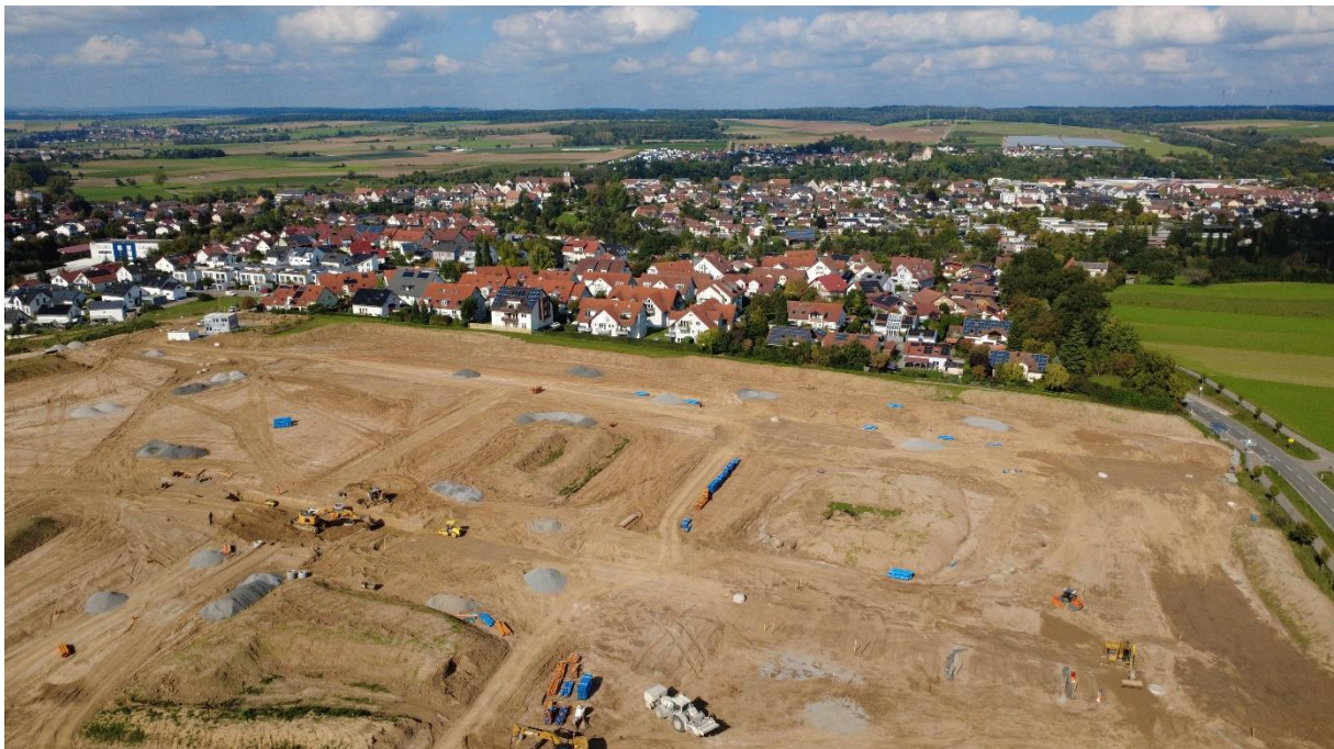
Die Erschließungsarbeiten haben bereits begonnen
