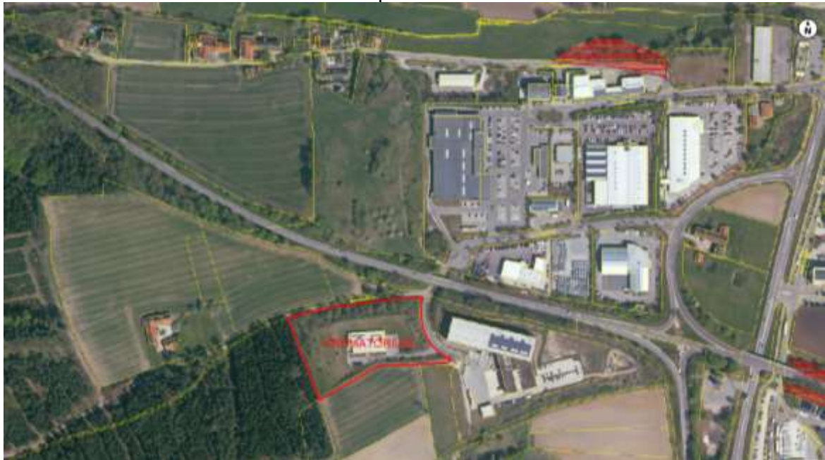
Geltungsbereich rot umrandet mit Bestandsgebäude
