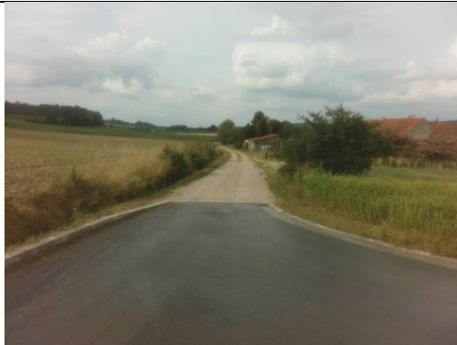
Blickrichtung von der Kramerbergstraße nach Nordosten in das geplante Baugebiet.
