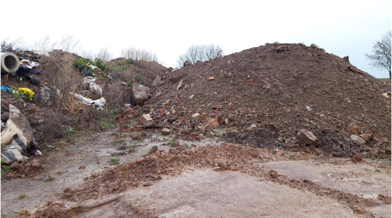
Bild 5: Haufwerk 4 - Aushub aus RRB 2 mit hausmüllähnlichen Bestandteilen (links)
