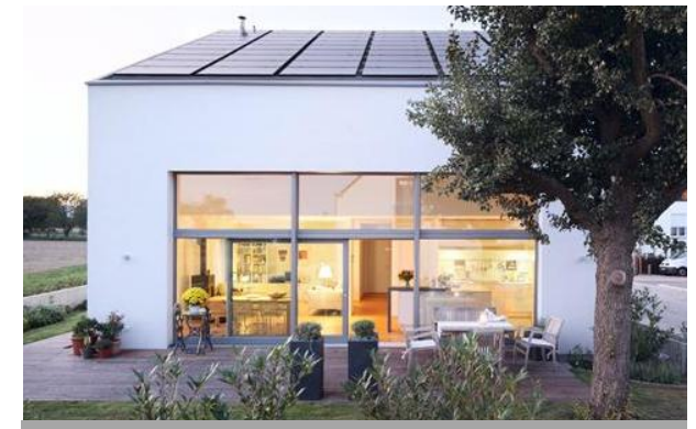
Beispiel Dachintegrierte Photovoltaik
