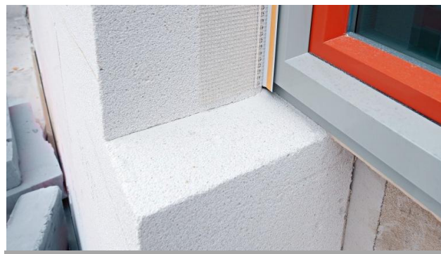
Beispiel Mineralfämmplatten auf Mauerwerk
