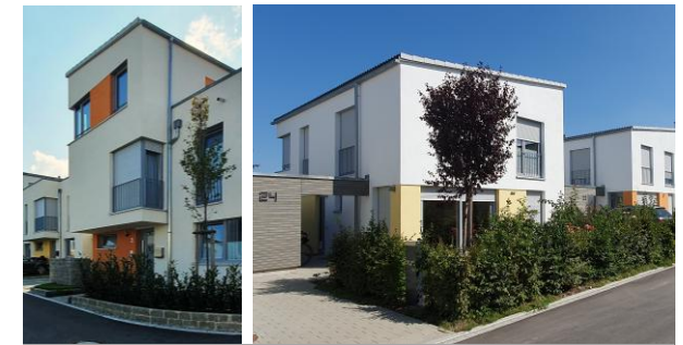
Vordach/ Überdachung Zugang Kettenhaus über Carport
