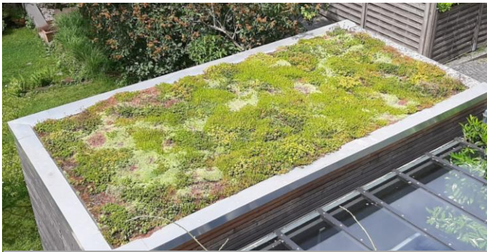
Beispiel Extensive Dachbegrünung auf Carports
