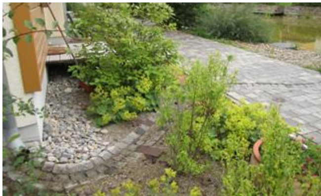
Beispiel Entwässerung des Dachflächenwassers mit Pflasterrinne
