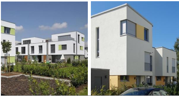
Fenster- und Fensterbänder mit Intarsien
