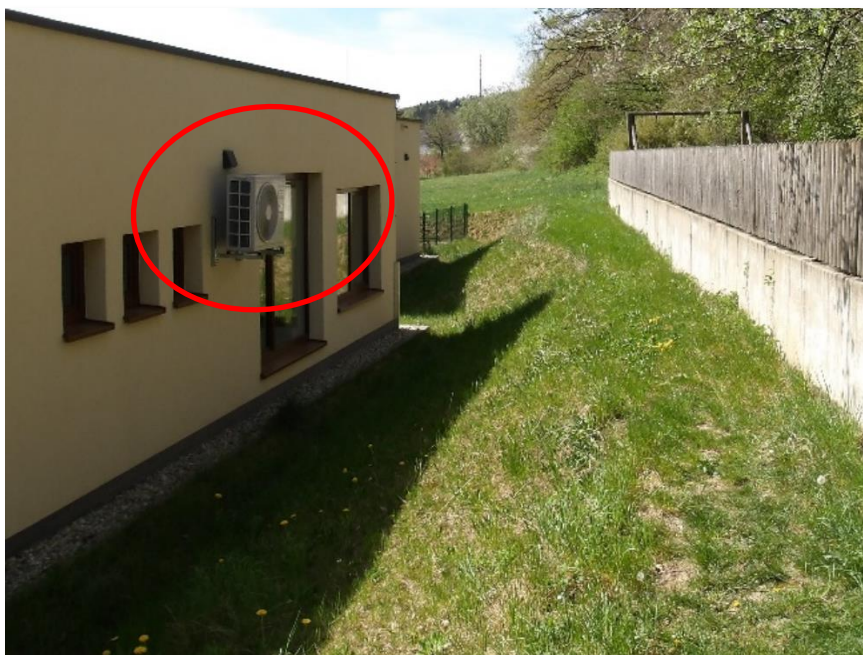
Abb. 59: Anordnung der Wärmepumpe außerhalb des Gefahrenbereichs
