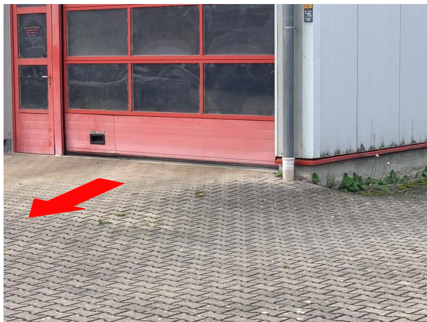
Abb. 52: Anordnung von Gargentoren über Geländeneiveau
