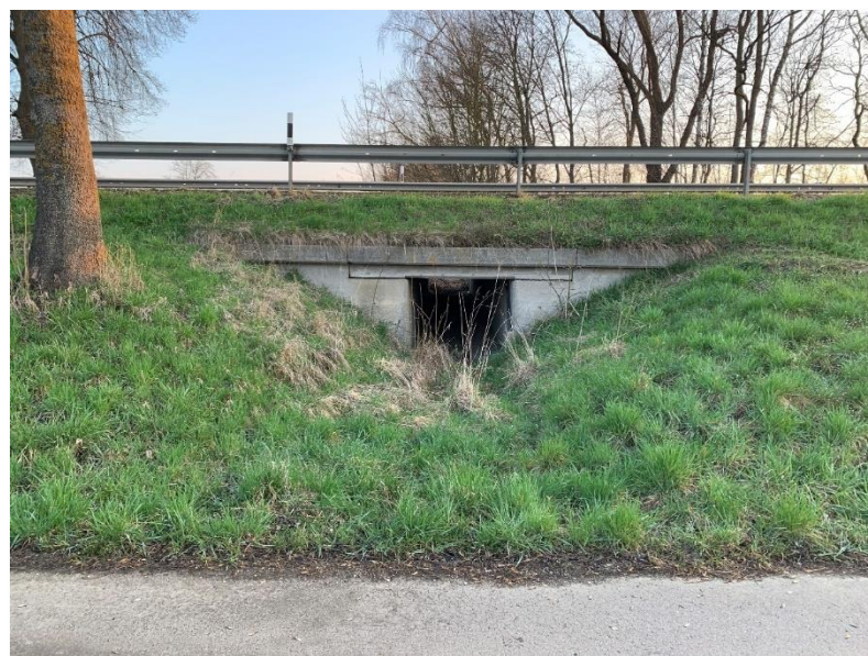
Abb. 16: Durchlass unter B8 in Richtung Geisling
