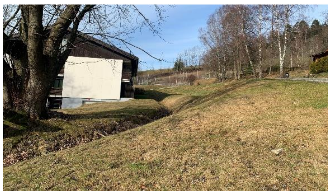
Abb. 50: Graben zum Abfangen vom Hangwasser
