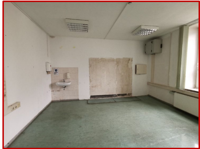
Raum im Hauptgebäude
