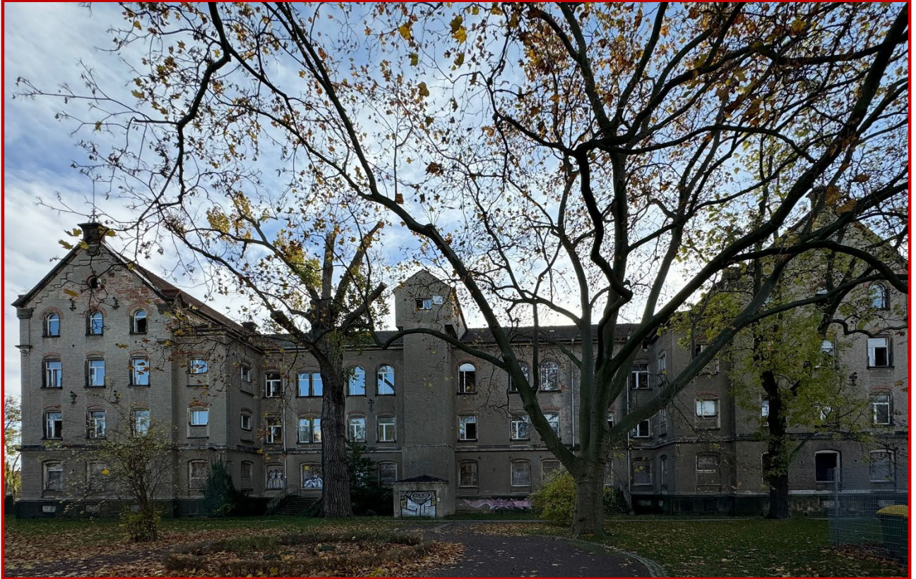
Vorderansicht ehemaliges Wohnheim
