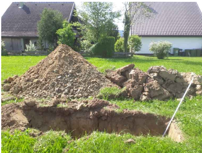
Bild 3: Baggergut aus Schurf SG 1.
