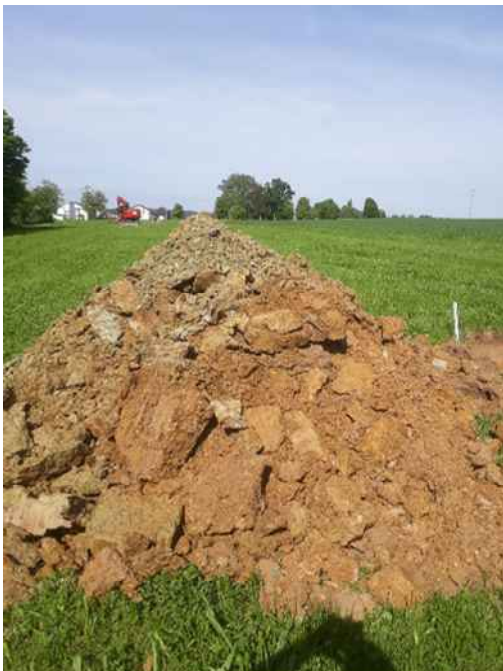
Bild 10: Baggergut aus Schurf SG 5.
