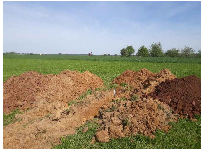
Bild 8: Baggergut aus Schurf SG 4
