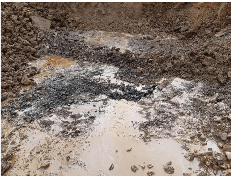
Abbildung 8 Verbleibende Restkontaminationen im gewachsenen Fels (Grubensole)
