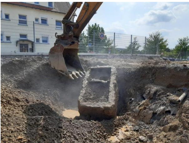
Abbildung 16 Auch kleinere Absetzbecken fanden sich unter der südlichen Werkstraße
