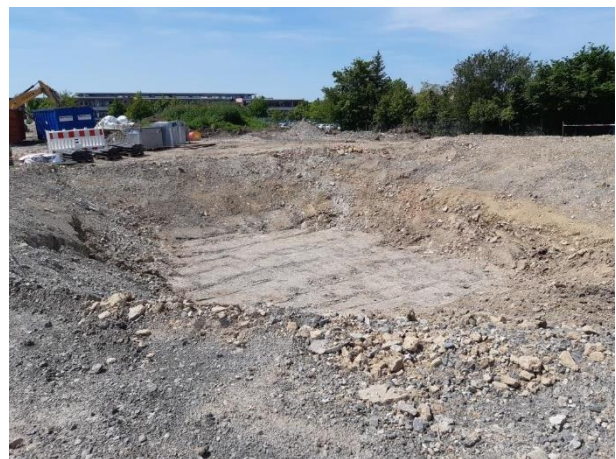
Abbildung 11 Benzinabscheideanlage unter Ru 116, vollständig ausgekoffert und wieder mit Naturschotter verfüllt und lagenweise verdichtet.
