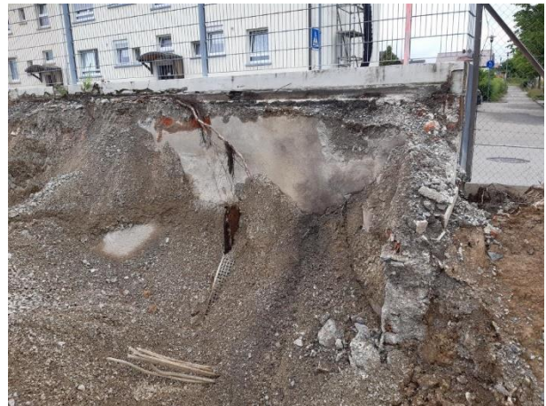
Abbildung 15 Weitere Absetzbecken unter südlicher Werkstraße, aus Stabilitätsgründen musste auch hier die Wand zur Robert-Bosch-Straße hin stehenbleiben
