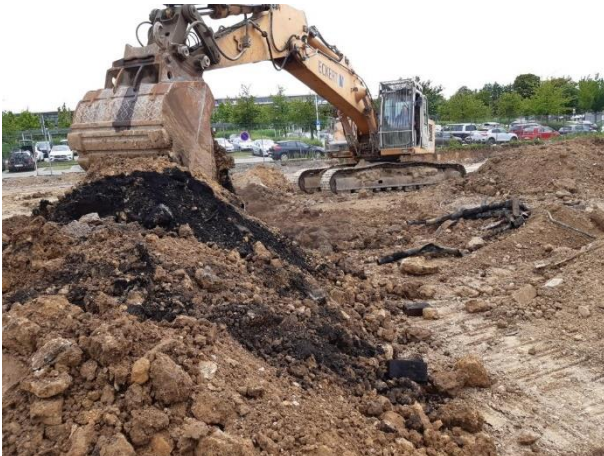
Abbildung 20 Stark mit MKW kontaminierte schwarze Schlacken zwischen Rasterfeld A 3 und A 4
