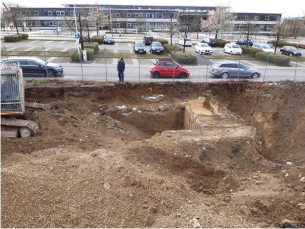
Abbildung 10 Absetzbecken Ru 119, bei Freilegung und nach Rückbau (Betonwände entlang der Robert-Bosch-Straße mussten aus Stabilitätsgründen verbleiben)
