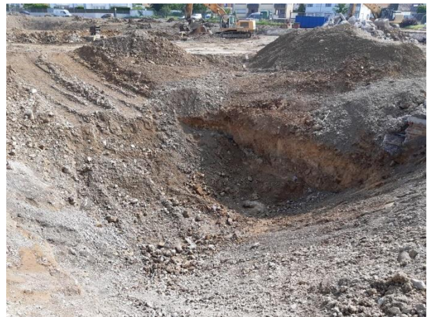
Abbildung 13 Galvanik-Absetzbecken unter Werkstraße, rückgebaut
