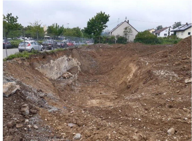
Abbildung 10 Absetzbecken Ru 119, bei Freilegung und nach Rückbau (Betonwände entlang der Robert-Bosch-Straße mussten aus Stabilitätsgründen verbleiben)
