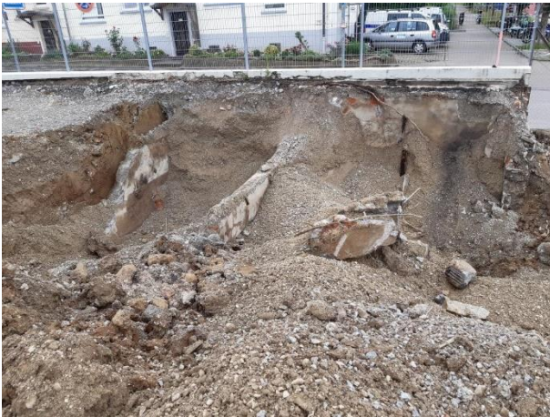
Abbildung 15 Weitere Absetzbecken unter südlicher Werkstraße, aus Stabilitätsgründen musste auch hier die Wand zur Robert-Bosch-Straße hin stehenbleiben
