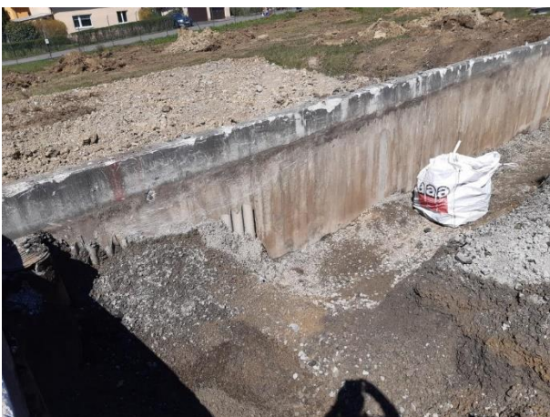
Abbildung 17 Das ehemalige Becken war innen mit Asbestzementplatten verkleidet, mit Schotter verfüllt und zur Nutzung als Parkplatz asphaltiert.
