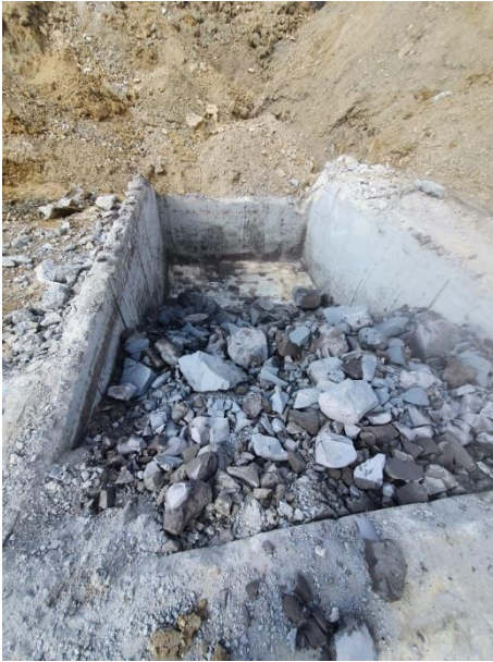
Abbildung 12 Absetzbecken unter Ru 109, vollständig ausgekoffert und rückgebaut
