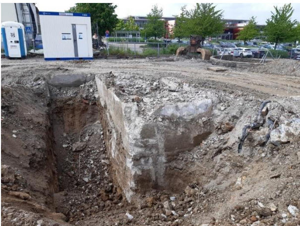
Abbildung 14 Schlammeindickbecken unter Gebäude Ru 107, beim Rückbau
