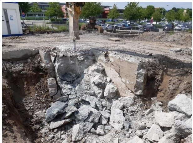
Abbildung 14 Schlammeindickbecken unter Gebäude Ru 107, beim Rückbau
