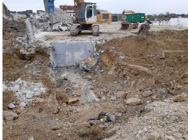
Abbildung 12 Absetzbecken unter Ru 109, vollständig ausgekoffert und rückgebaut
