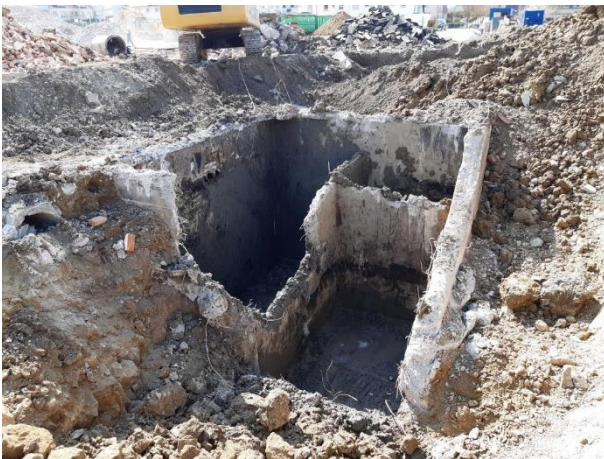
Abbildung 11 Benzinabscheideanlage unter Ru 116, vollständig ausgekoffert und wieder mit Naturschotter verfüllt und lagenweise verdichtet.
