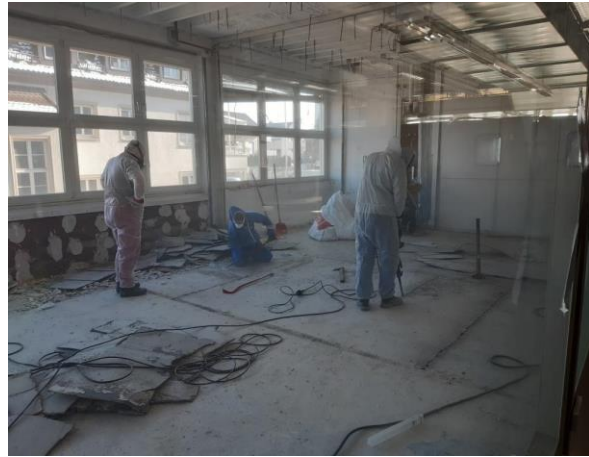
Abbildung 2 Rückbau KMF und Asbestestrich Gebäude Ru 109 und Ru 101
