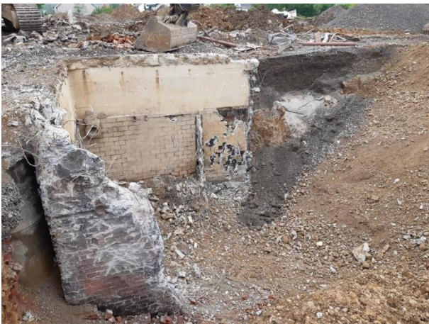
Abbildung 13 Galvanik-Absetzbecken unter Werkstraße, rückgebaut
