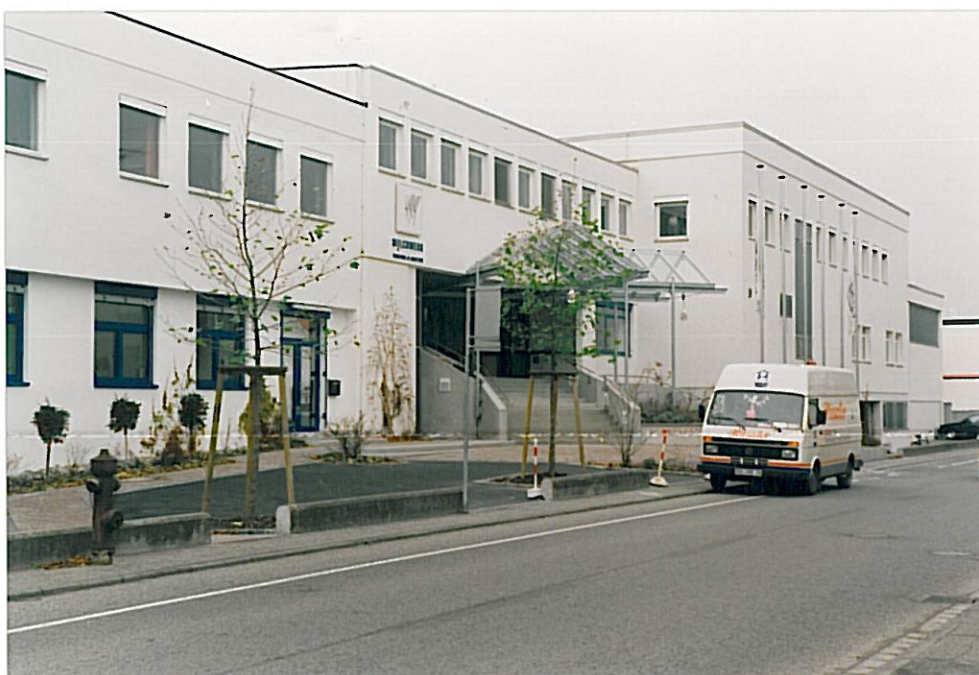
Ehemalige Molkerei Milchwerk Radolfzell, Aufnahmeperspektive: von der Güttingerstraße aus
