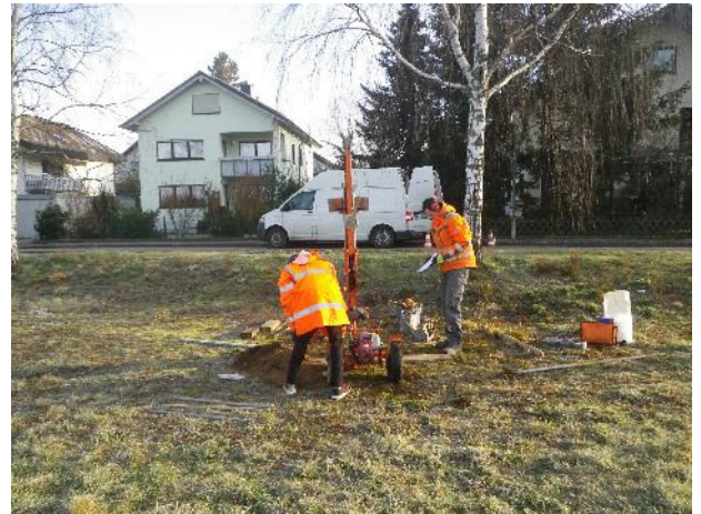
Foto 2: Rammsondierung bei RKS 1 / DPH 1
