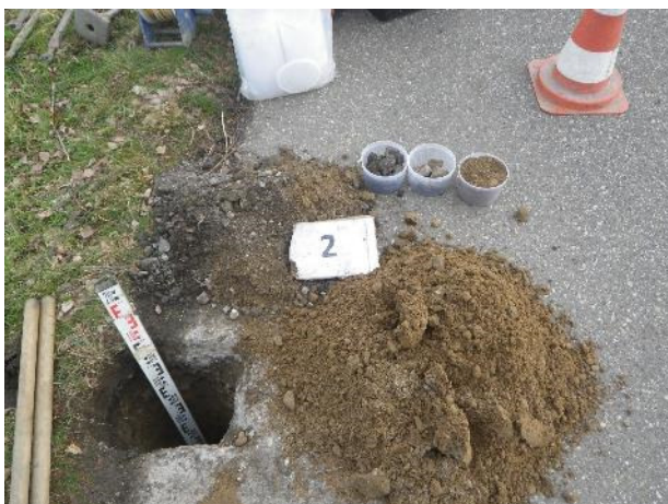
Foto 11: Aushub bei SCH 2
