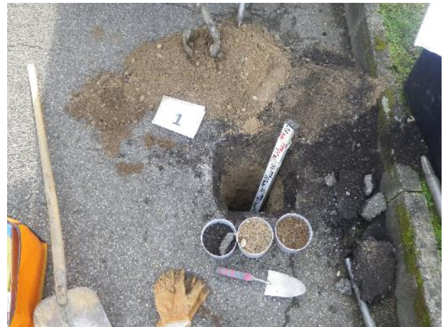
Foto 10: Handschurf und Aushub bei SCH 1
