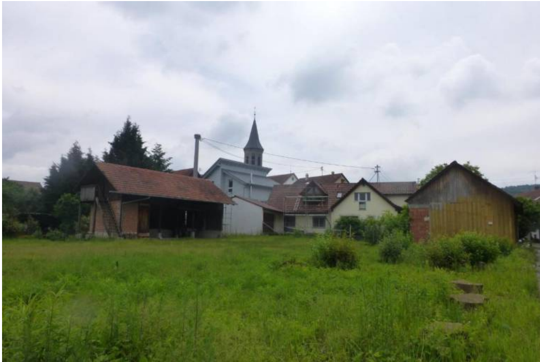
Abbildung 6: Scheuengebäude im östlichen Teil
