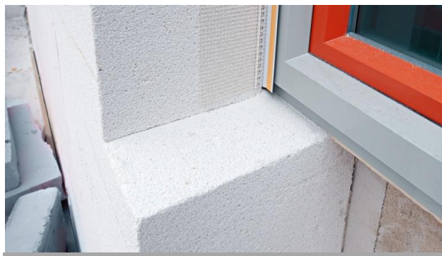
Beispiel Mineralfaserplatten auf Mauerwerk
