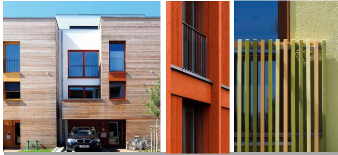
Flachstahlgeländer / Integration Sonnenschutz
