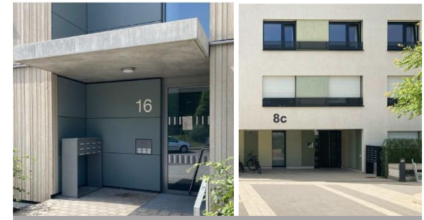
Eingangssituation mit Vordach/ Überdachung
