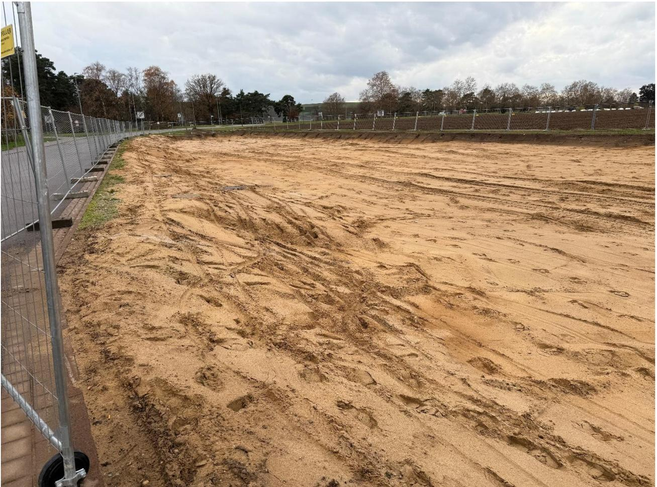
**Bild 1: Oberfläche nach erfolgter Bodensanierung, 26.11.2024**
