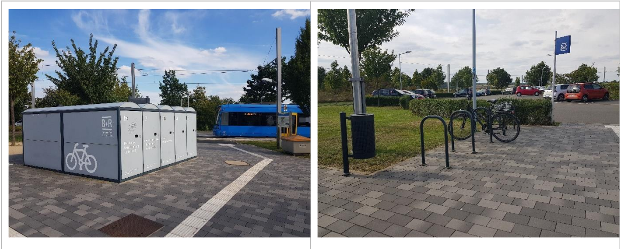
Abbildung 77: Gute Abstellmöglichkeiten bei der Straßenbahnhaltestelle. Die Installation einer Überdachung würde die Lösung verbessern.
