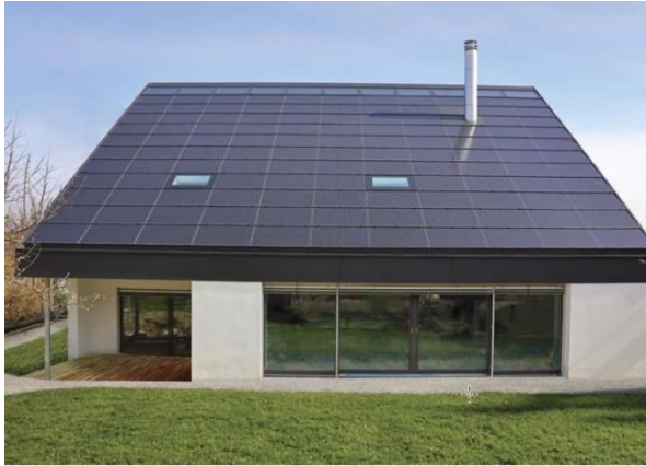
Abbildung 55: Foliensolarmodule für geringe Dachlasten (alwitra GmbH & Co. Klaus Göbel, 2017)
