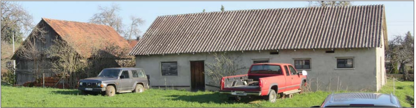
Ansicht aus Süden auf die vorhandenen Schuppen im Gebiet
