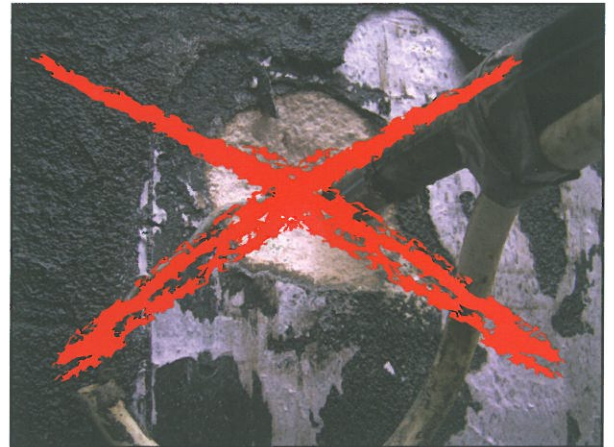
Nicht fachgerechte Einbindung der Gebäudeabdichtung
