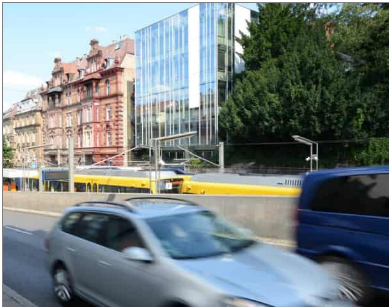
Abbildung 18: Bsp. Lärmsanierung eines Bestandsgebäudes durch eine vorgehängte, hinterlüftete Fassade an der Hohenheimer Straße in Stuttgart
