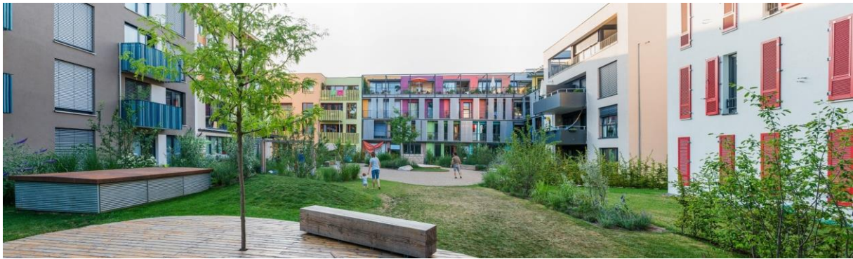
Abbildung 11: Best-Practice-Beispiel Fassadengestaltung Alte Weberei, Tübingen © Universitätsstadt Tübingen
