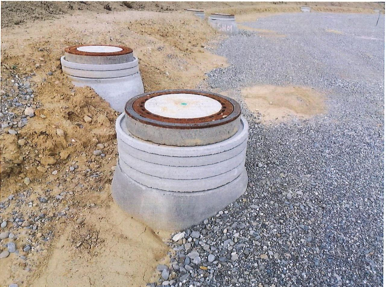
Die jeweiligen Haus- bzw. Grundstücksanschlüsse sind innen markiert bzw. beschriftet so dass man hier keinen Anschlussfehler machen kann, somit ist klar gekennzeichnet welcher der Regenwasseranschluss bzw. -schacht ist und welcher der Schmutzwasseranschluss bzw. -schacht jedes einzelnen Grundstückes ist.
