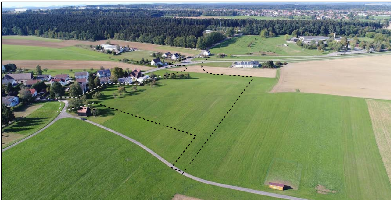
Drohnen-Luftbild mit dem Plangebiet aus südlicher Richtung aufgenommen
