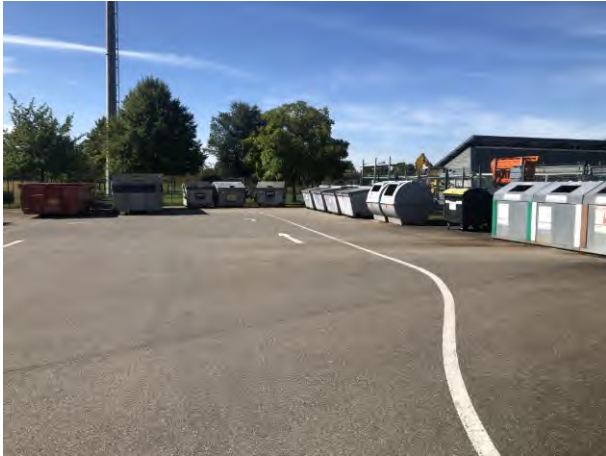
Abb. 2.4-19 Vollständig versiegelter Bau- und Recyclinghof
