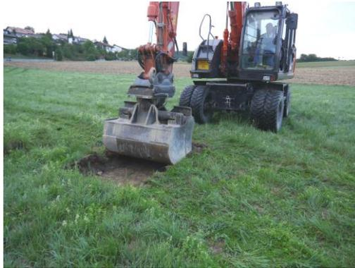
Abb.21: Ausführung Baggerschurf am Ansatzpunkt BS 10/15
