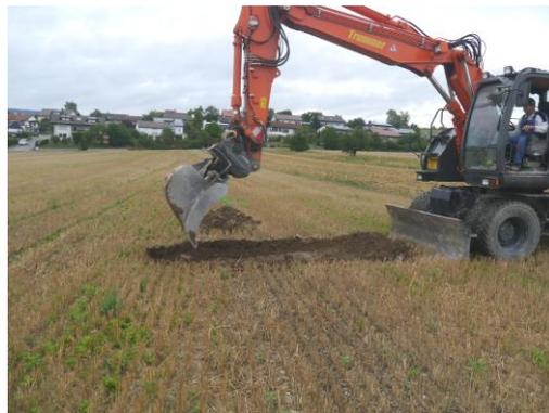
Abb.13: Ausführung Baggerschurf am Ansatzpunkt BS 6/15
