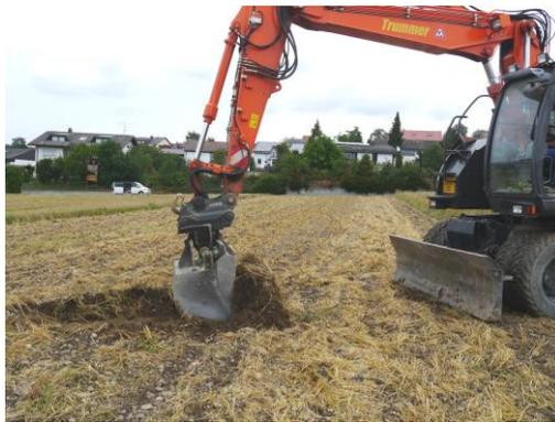
Abb.9: Ausführung Baggerschurf am Ansatzpunkt BS 4/15
