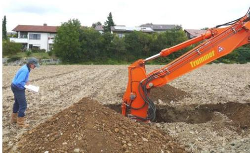
Abb.5: Ausführung Baggerschurf am Ansatzpunkt BS 2/15
