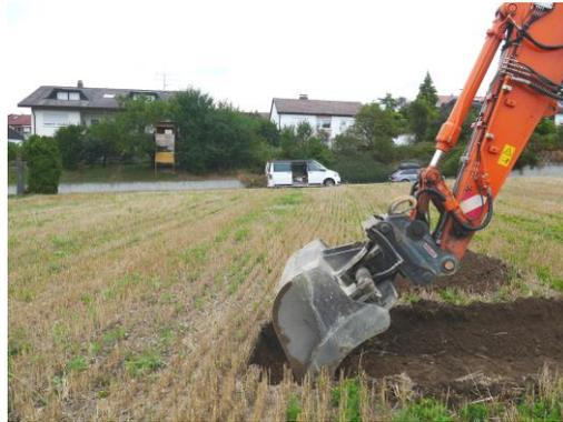
Abb.3: Ausführung Baggerschurf am Ansatzpunkt BS 1/15
