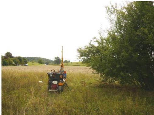
Abb.6: Schwere Rammsondierung am Ansatzpunkt DPH 2/15
