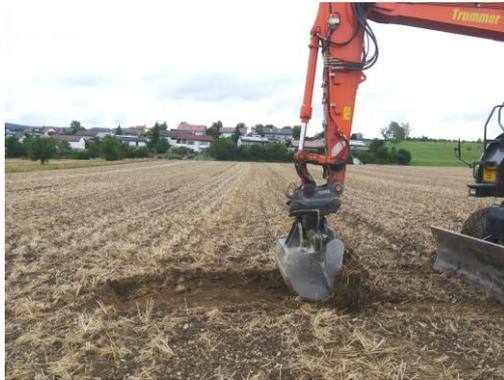
Abb.15: Ausführung Baggerschurf am Ansatzpunkt BS 7/15
