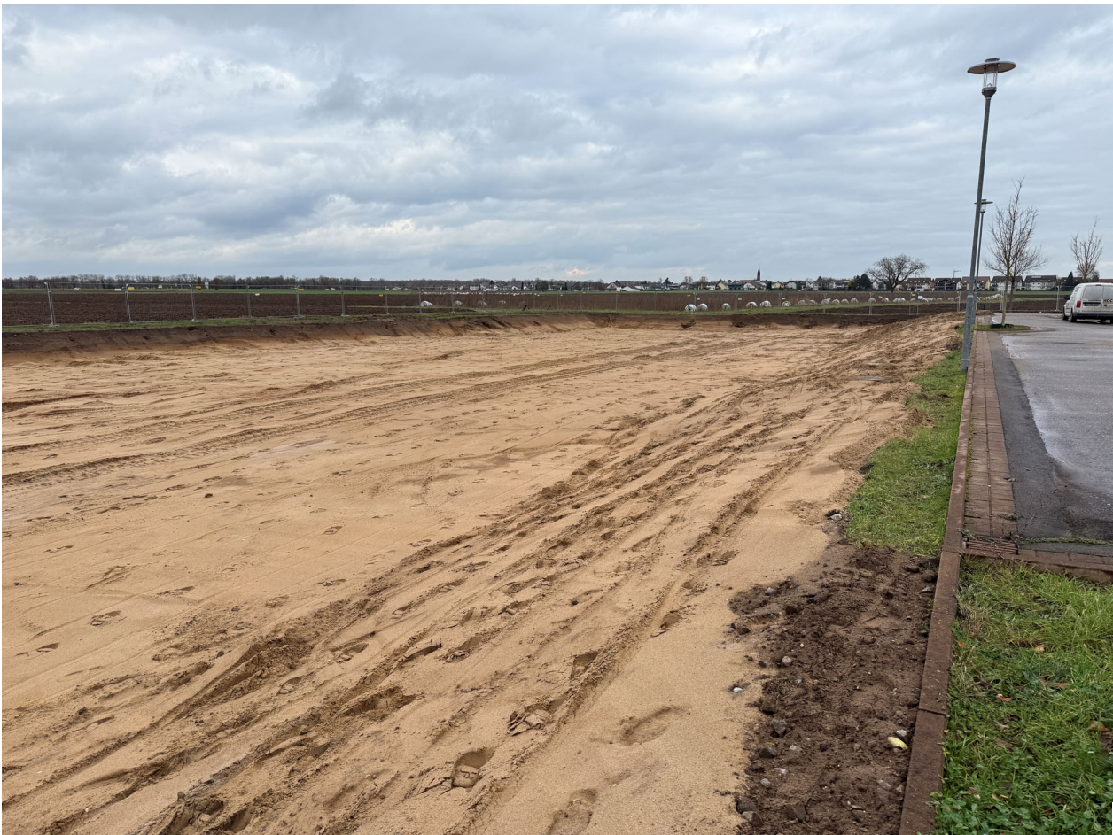
Bild 1: Oberfläche nach erfolgter Bodensanierung, 03.12.2024
