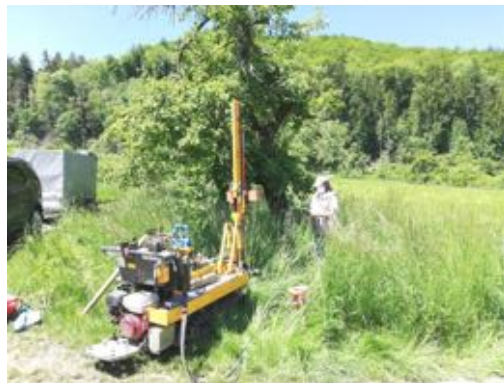
Abb.11: Schwere Rammsondierung am Ansatzpunkt DPH 1/21
