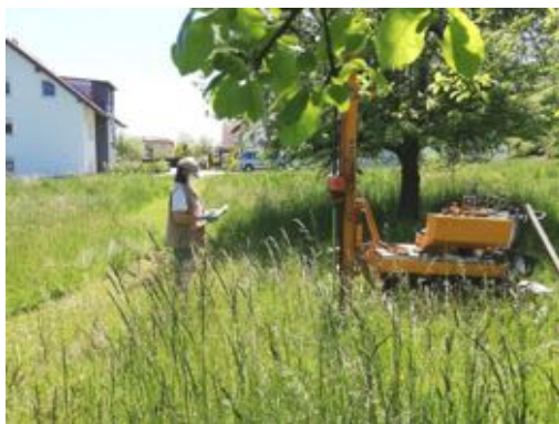
Abb.13: Schwere Rammsondierung am Ansatzpunkt DPH 3/21
