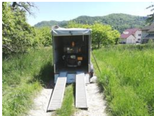
Abb.4: Anlieferung des Raupensondierfahrzeuges
