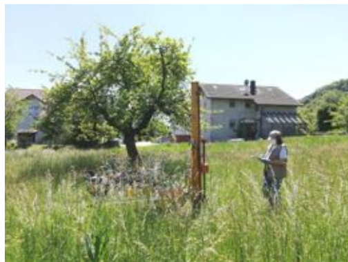
Abb.12: Schwere Rammsondierung am Ansatzpunkt DPH 2/21
