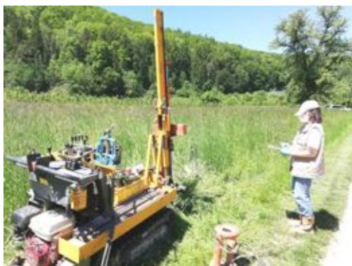
Abb.14: Schwere Rammsondierung am Ansatzpunkt DPH 4/21
