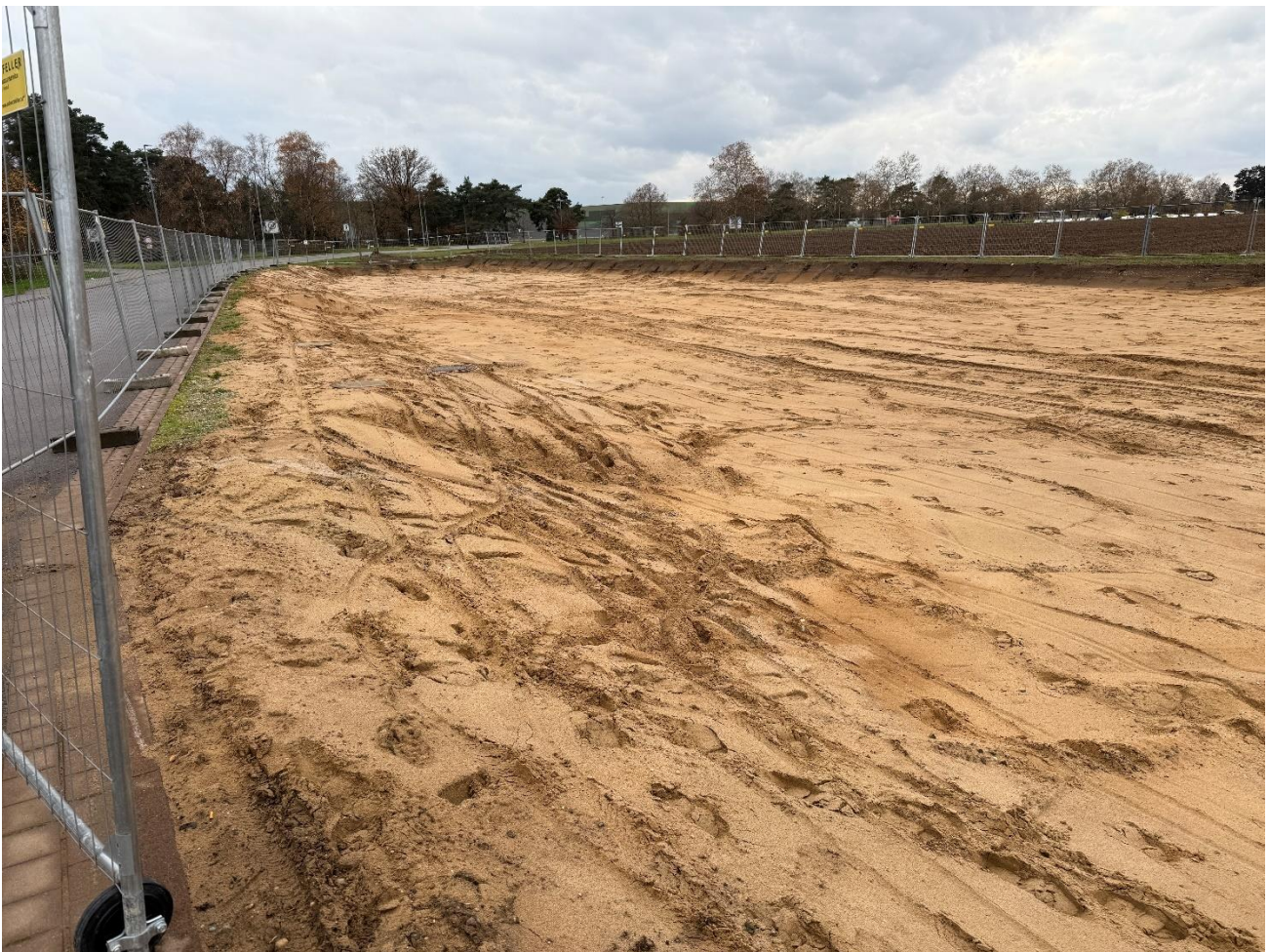
Bild 1: Oberfläche nach erfolgter Bodensanierung, 26.11.2024
