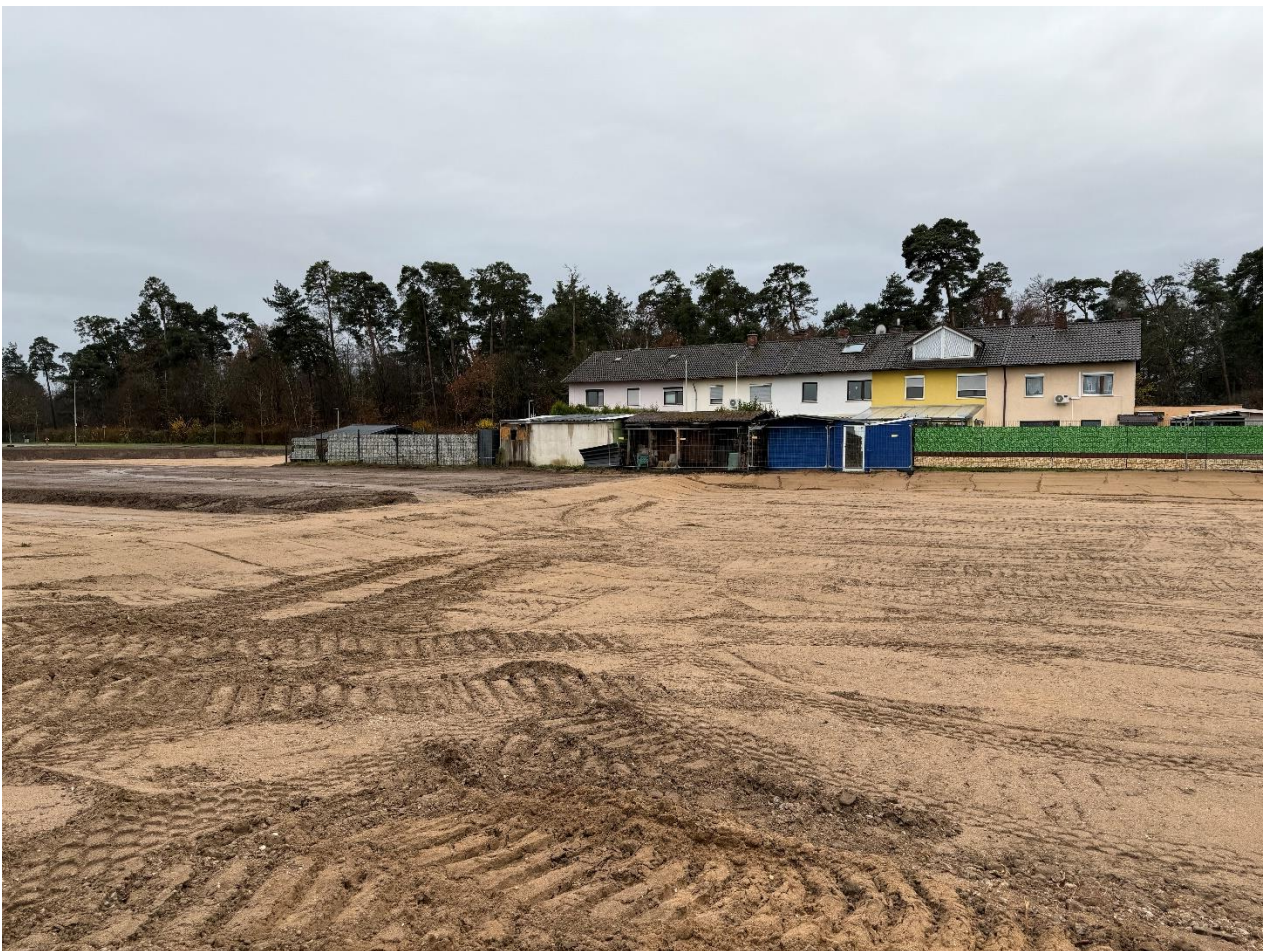
Bild 1: Oberfläche nach erfolgter Bodensanierung, 03.12.2024
